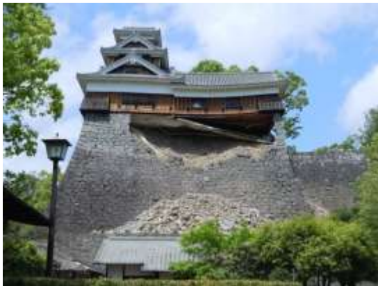
Beschädigtes Schloss Kumamoto
